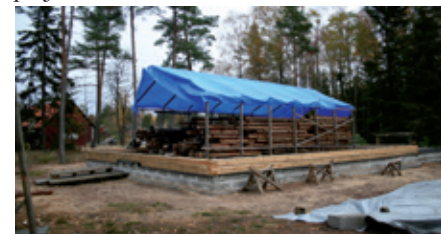
Grunden ligger där och nu monteras kapellet ihop
